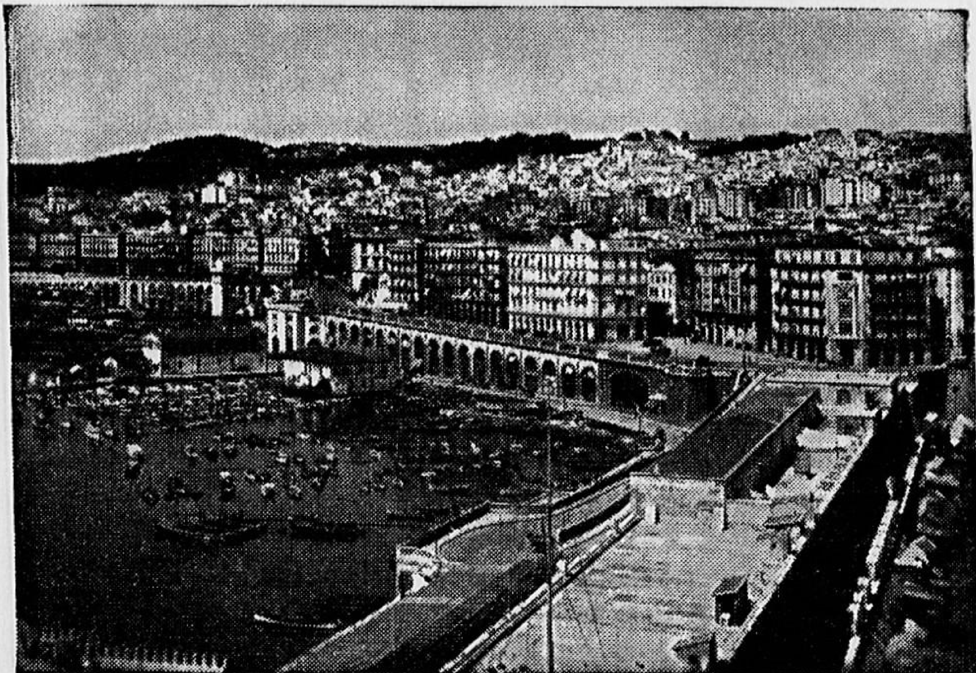
Alger. — Vue générale prise du Port (Photo OFALAC)
