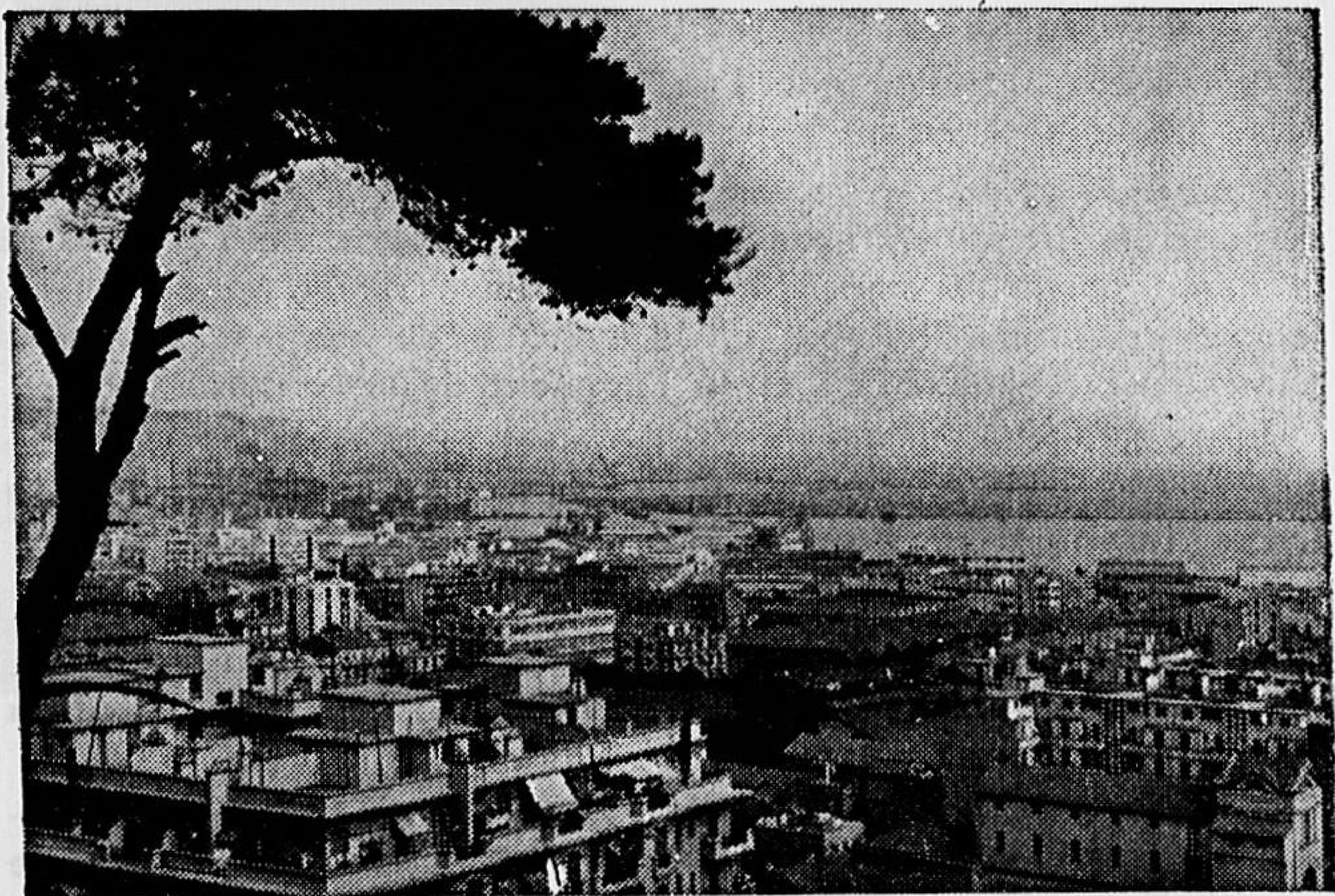
Alger. — Vue générale prise du boulevard Bru. (Ph. Ofalac.)
